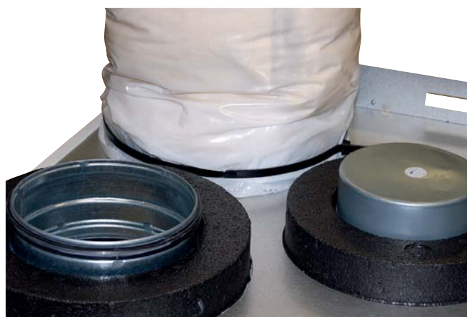
Ferdig montert kanal.
